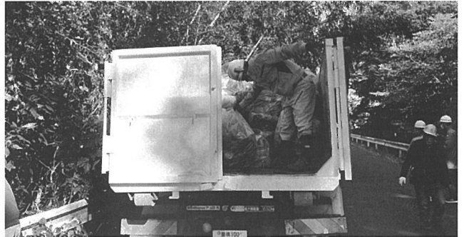
廃棄物撤去の様子
