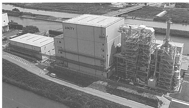
リサイクルプラント東浦工場（出典：同社ホームページより）
