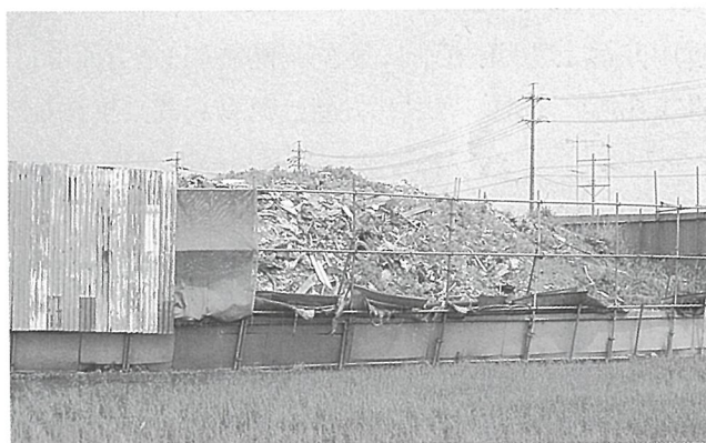
田んぼに崩れ落ちそうな廃棄物の山
