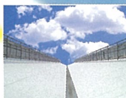
防水性に優れたラース 工法によりスレート屋 根の補修などで工場全 体を再生します。
