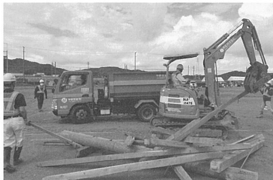
擬似災害廃棄物を油圧ショベルで挟み、中部保全（株）の車両に積み込む。
