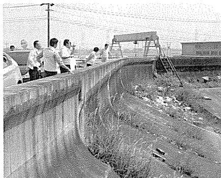
筏川堤防の不法投棄現場
